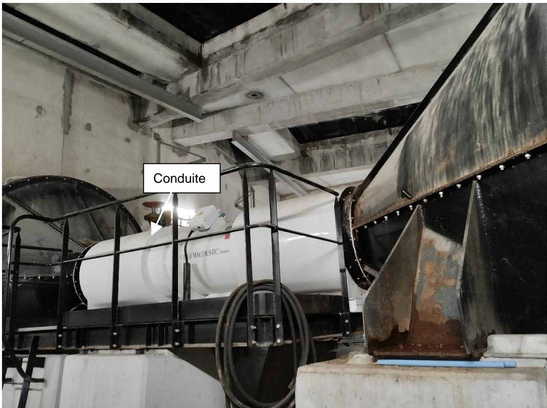
*Photo 8 : Conduite de ventilation maintenue*
