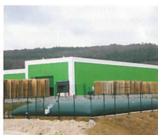
Citerne de défense incendie 240m³ avec INC14 sur une zone industrielle
